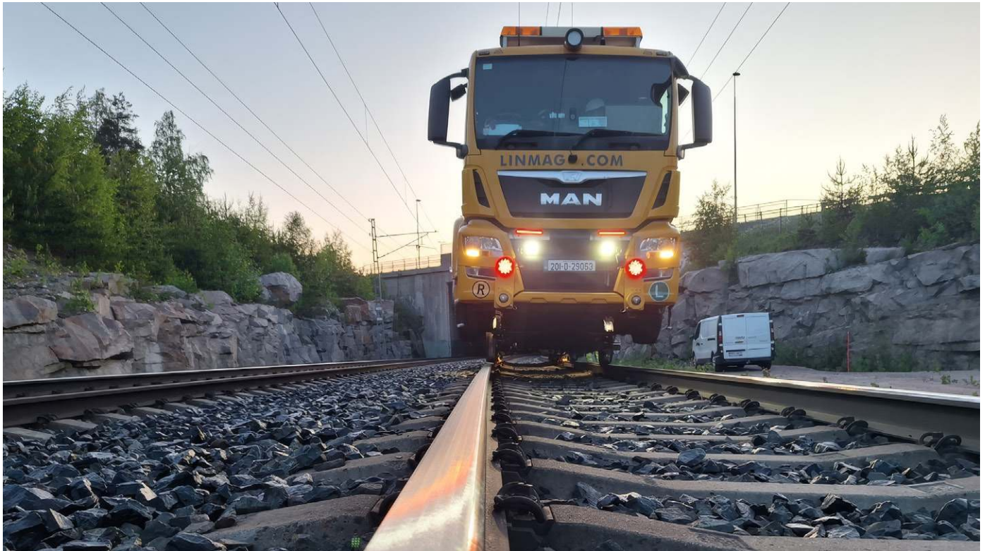
Abb. 1: Schienenfräsmaschine „SF02W-FS Truck“ bei Fräsarbeiten in Helsinki, Finnland (mit neu profilierter Schiene im Vordergrund)
