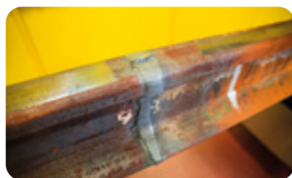
сварной шов перед обработкой
