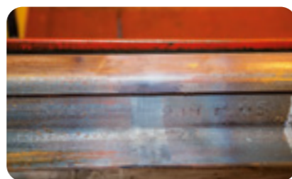
сварной шов после обработки
