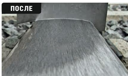
Отличный профиль головки рельса в результате обработки с использованием технологии фрезерования рельсов фирмы LINSINGER.
