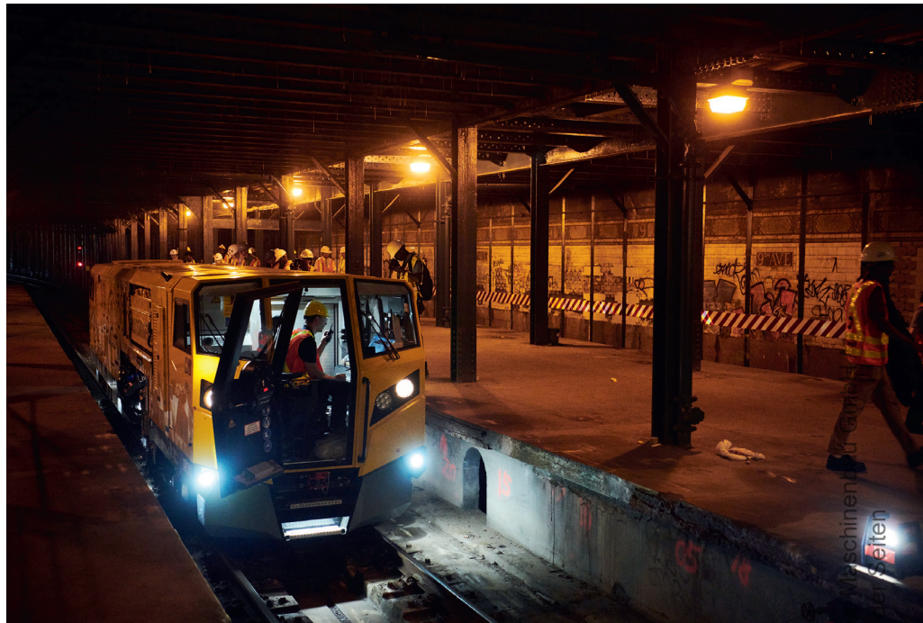
Abb. 5: Die mobile Hochleistungsfräsmaschine im Einsatz in einer Station von NYCTA.
