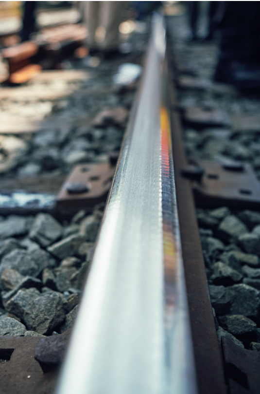
Abb. 4: Die Schienenoberfläche nach nur einer Überfahrt – vollständige Entfernung der Schädigung und exakt eingestelltes Zielprofil
