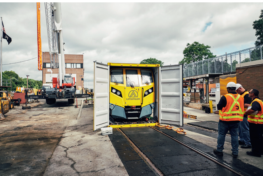
Abb. 2: Fräse MG11 im 40 Fuß-Container kurz vor dem Eingleisen im Depot von NYCTA
